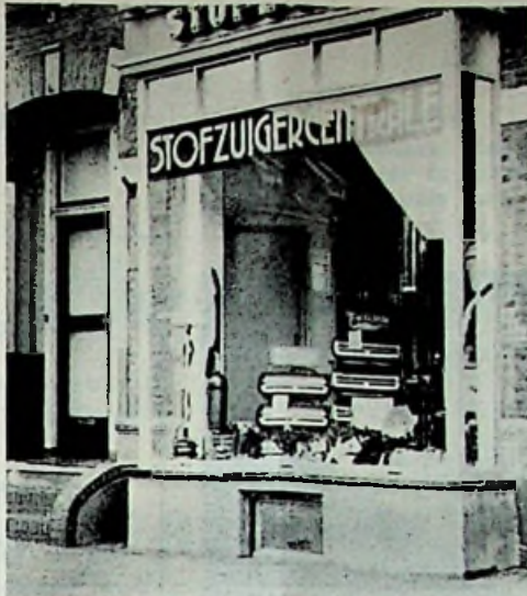
De voorgevel van de nieuwe stofzuigercentrale aan de Graafseweg te Nijmegen.
